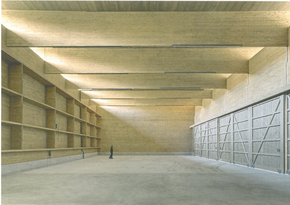
Die schlanken Dachbinder prägen die hohe Werkhalle des Wasserbauwerkhofs Neugut bei Andelfingen
