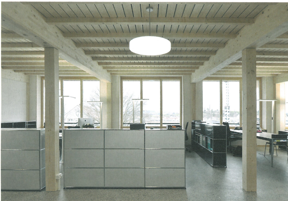
Sichtbare Holzkonstruktion und geschliffener Betonboden im zweiten Obergeschoss des Gartenbauwerkhofs in Winterthur-Hegiberg.
